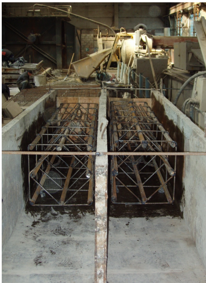
Рисунок 1. Встановлення арматурних каркасів в опалубку.
