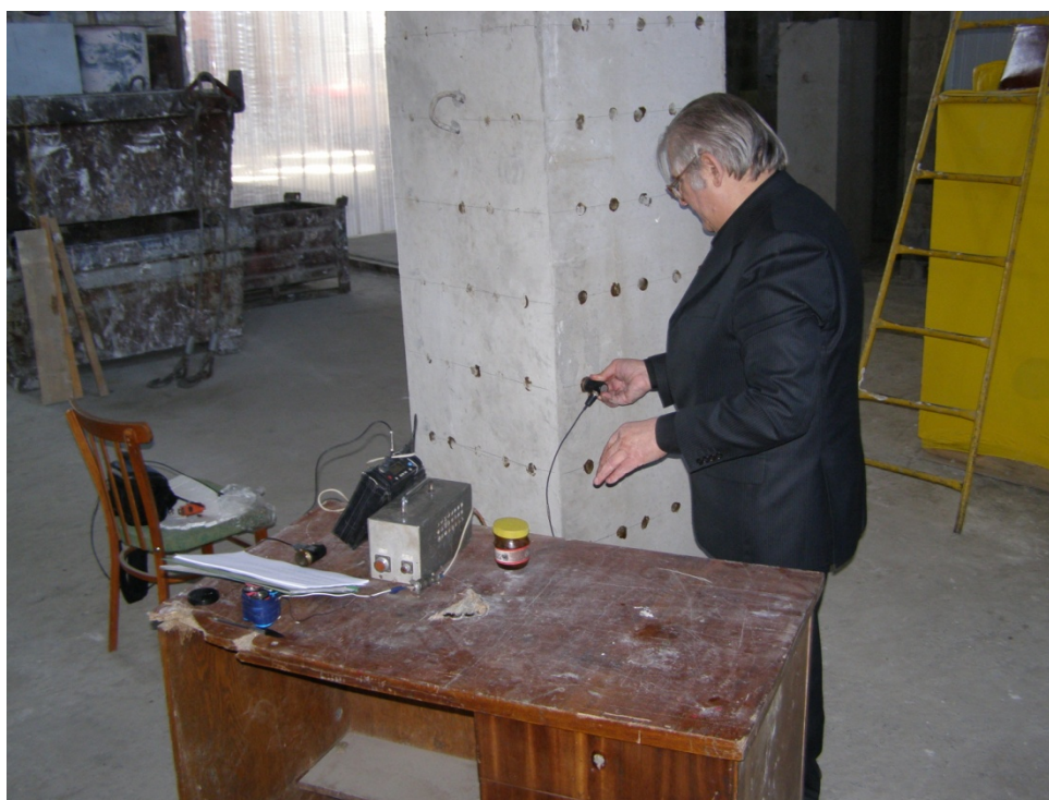
Рисунок 2. Виконання випробувань бетону колони ультразвуковим методом.
