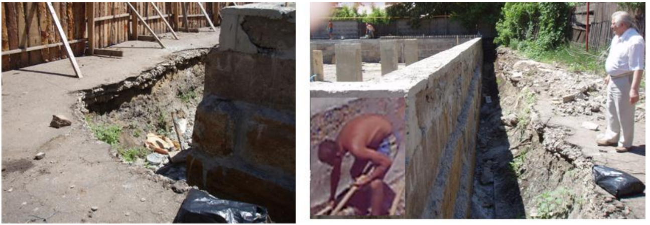
Рисунок 2 - Общий вид участка и отбор монолитов под фундаментом из шурфа (Ш-1).
