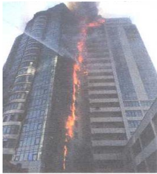
Рис. 2. Поширення полум'я по конструкціям фасаду житлового будинку
